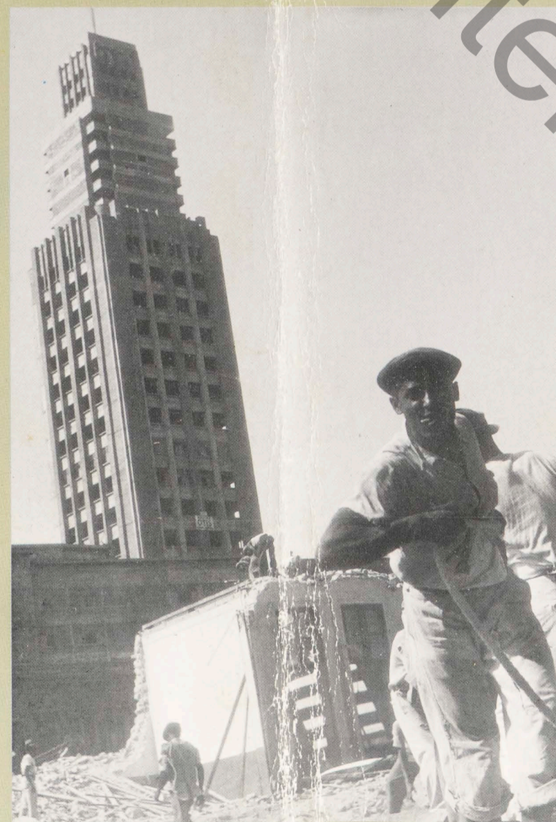
Construção do prédio da Central de Brasil entre 1938 e 1940 Fundação Getúlio Vargas/CPDOC Foto Peter Lange
