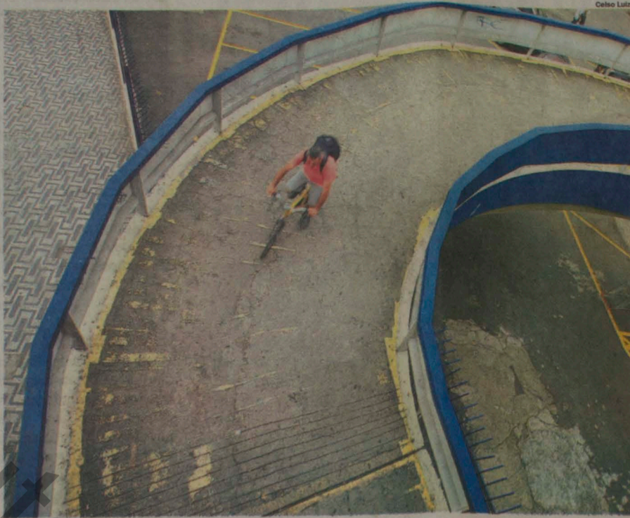
Passarelas e viadutos de Santo André vão receber pintura e limpeza; reforma não está prevista
