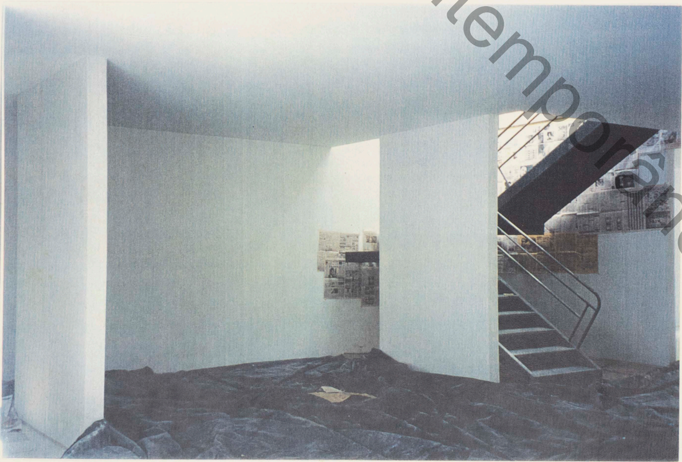
Vista parcial salas piso inferior
