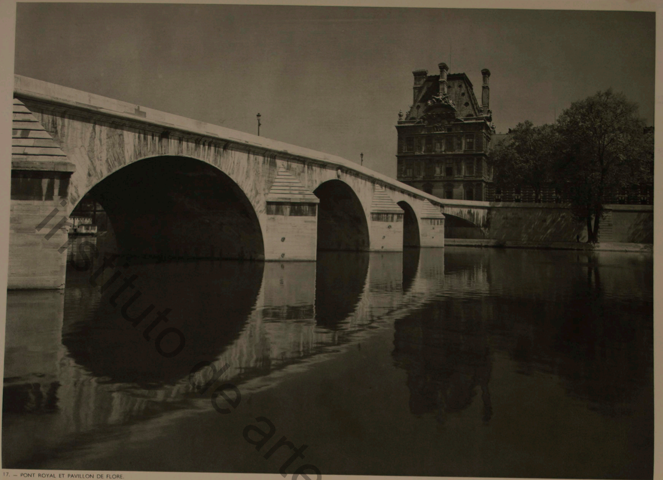
17. — PONT ROYAL ET PAVILLON DE FLORE.
