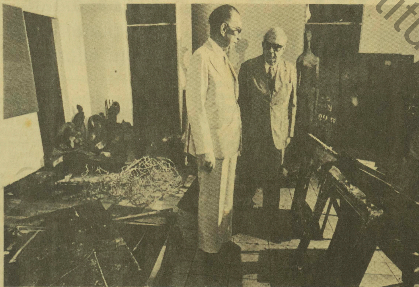
Edson Motta (de branco; com Manoel Diegues) prometeu restaurar 50 obras
